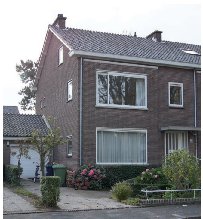
1.4 – Ambachtelijke bouwwijze en sobere detaillering bij vroeg-naoorlogse woningen.
