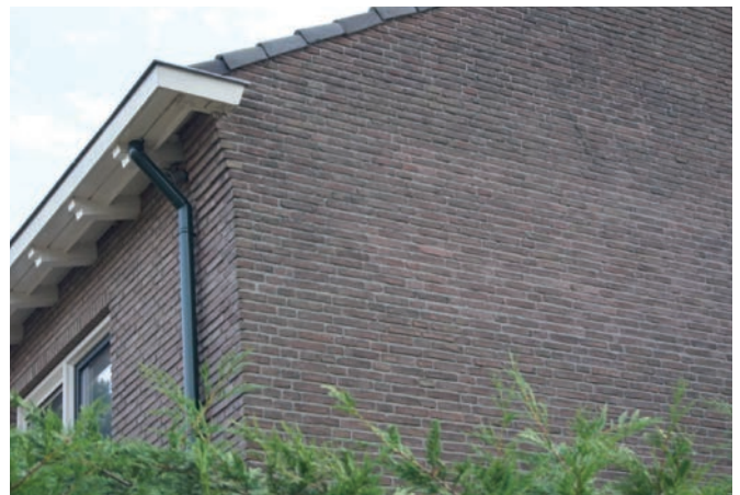
3.6 – Dak- en gootconstructies werden in de vroeg-naoorlogse bouwperiode nog vaak op traditionele wijze uitgevoerd.
