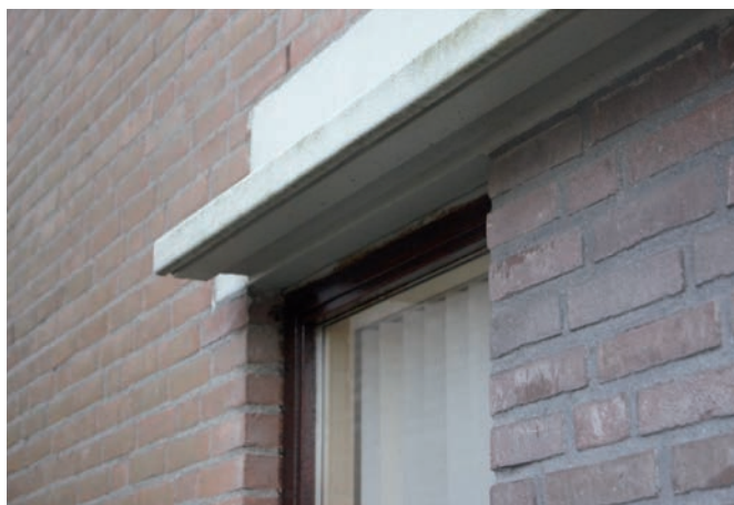
3.12 - Neuslatei op een niet gebruikelijke manier toegepast als zelfdragende schoonwerk latei.
