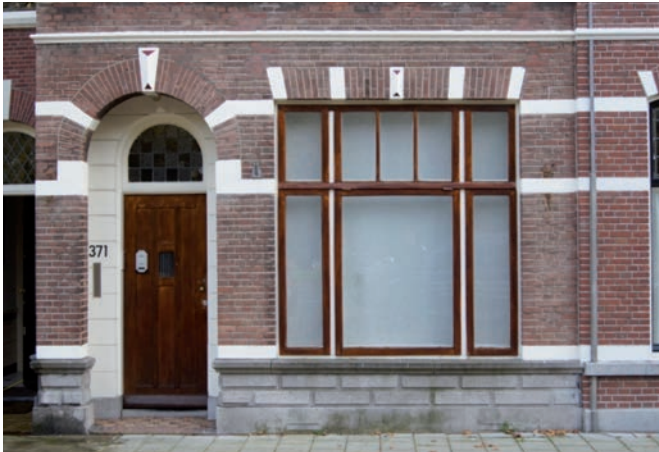
3.2 – Rondboog boven portaal (links) en schuine stek boven houten kozijn (rechts).
