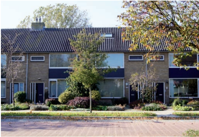
3.7 – Grote glasoppervlakken zijn kenmerkend voor de doorzonwoningen die ten tijde van de woningnood veelvuldig gebouwd zijn.
