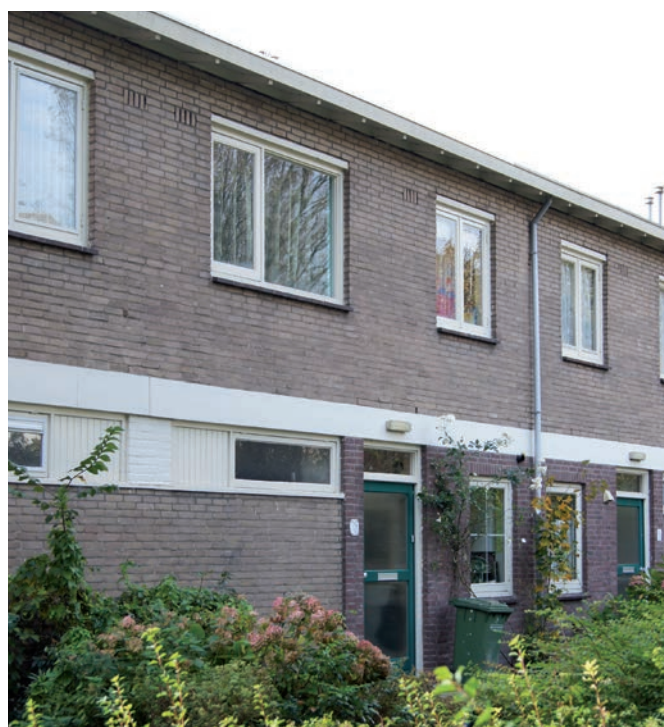
1.5 – Sobere detaillering en koudebruggen ter plaatse van de gevel zijn kenmerkend voor de “woningnoodwoningen”.
