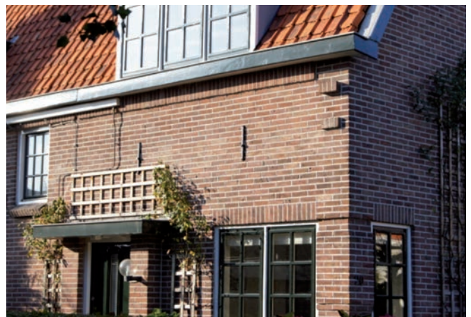
3.3 – Schotelankers leveren een kenmerkend vooroorlogs gevelbeeld op.
