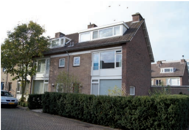
3.5 – Toenemende standaardisatie aan het eind van de vroeg-naoorlogse bouwperiode is met name zichtbaar aan de gevelopeningen.
