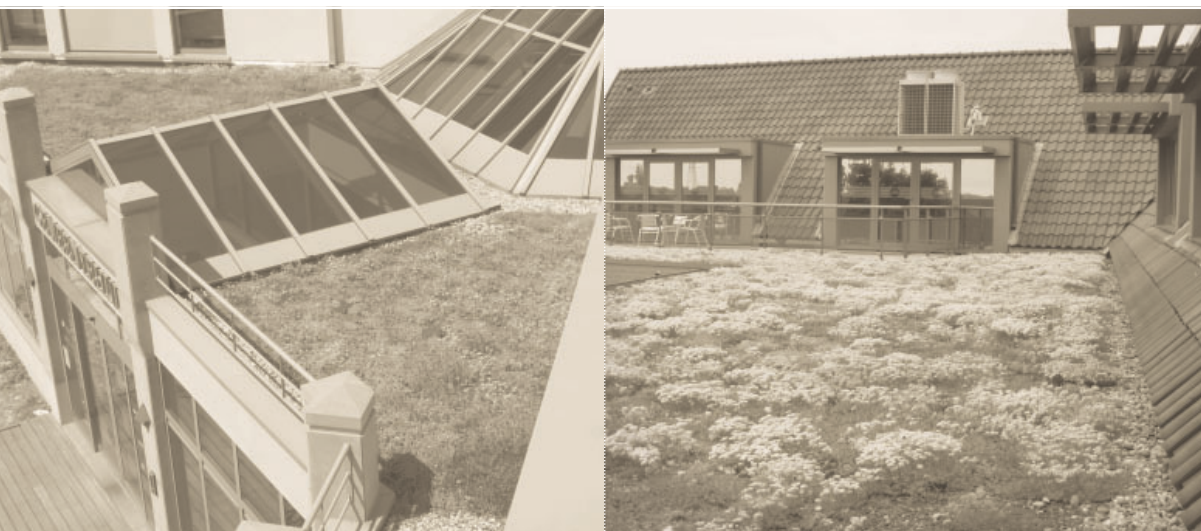
■ □ Lubbeek: dak van het administratief centrum. □ ■ Dak van de bibliotheek van Herentals.
