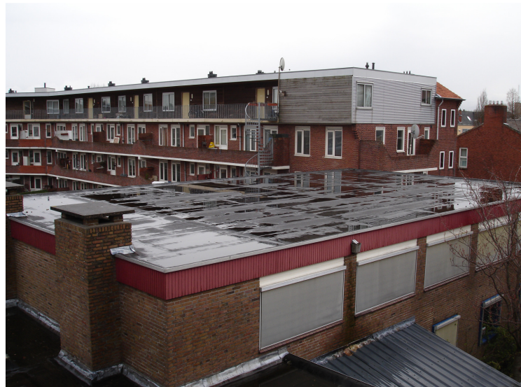
Figuur 12: het dak van de gymzaal bij de van dokkumschool in zijn huidige staat (foto: Mandema, 2008)
